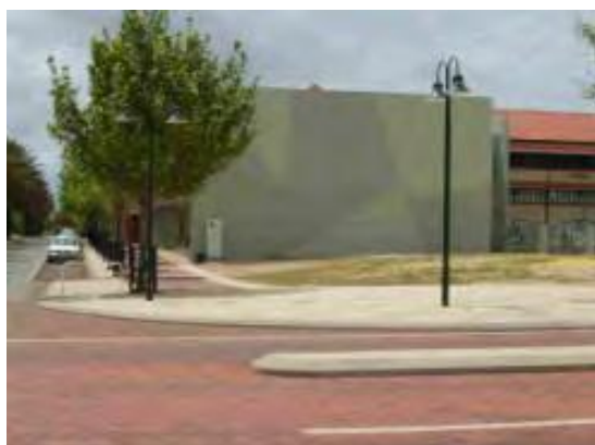
Figura 2 Evitar muros sem utilização que escondem a vigilância natural e encorajam a pichação
