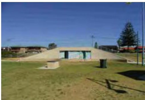
Figura 62 Evitar projetos e ambientes que proporcionem o bloqueio da vigilância natural para banheiros públicos.
