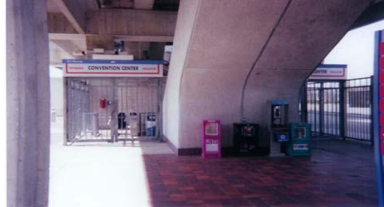
Figura 65 Identificação e controle de acesso é uma maneira de dissuasão do potencial agressor.
