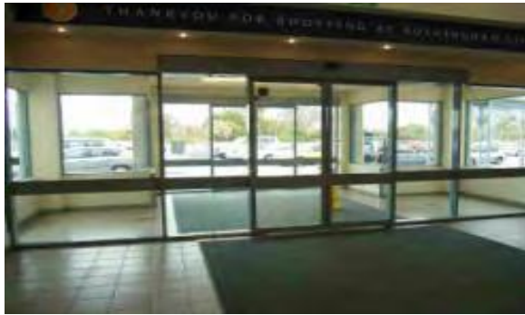
Figura 5 O projeto da entrada e saída da edificação deve permitir clara identificação e melhor campo de visão, minimizar o potencial de esconderijos – o projeto deve permitir visualização clara.
