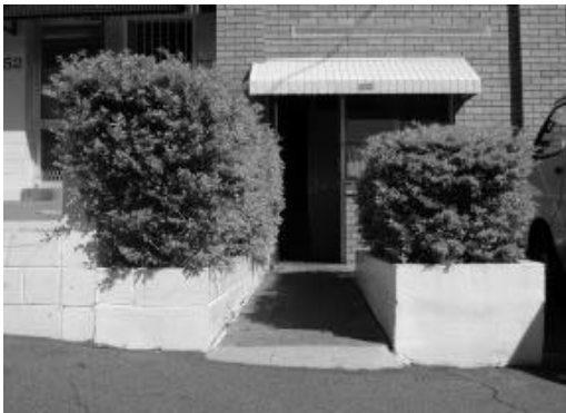
Figura 10 Acesso identificado mas com baixa possibilidade de vigilância e com a possibilidade de esconderijo.
