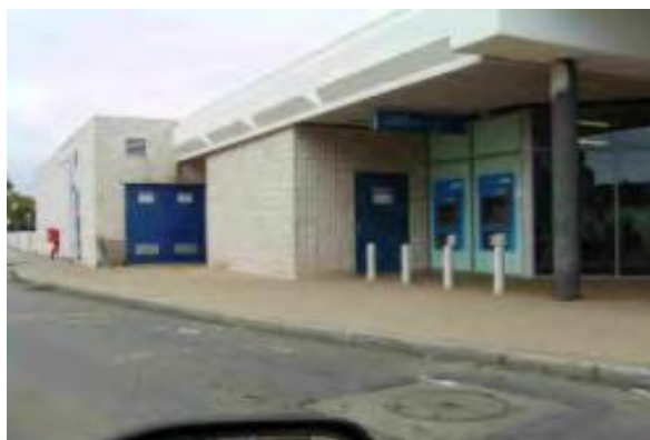
Figura 61 Diversos elementos arquitetônicos 'concavos' ou que promovam a falta de visibilidade, criam potenciais ameaças ao redor de caixas eletrônicas.
