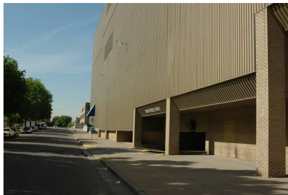
Figura 25 A concepção arquitetônica das edificações deve se preocupar com a garantia da vigilância natural de todo seu perímetro. Este é um exemplo da falta da aplicação dessa regra.
