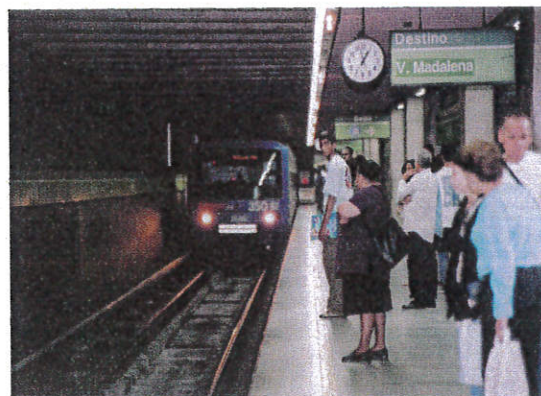
Ramal Paulista do metrô de São Paulo, que não possui sistema de ventilação e exaustão nas estações e túneis
