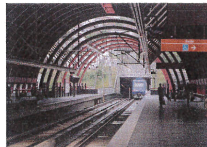
A estação Dom Bosco da CPTM foi concebida inicialmente para ser mais uma linha do metrô
