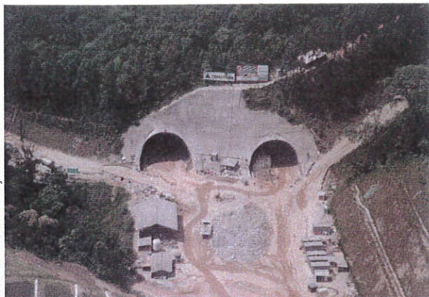
Túnel do Rodoanel em construção, que contará com modernos recursos de segurança contra incêndios e emergências
