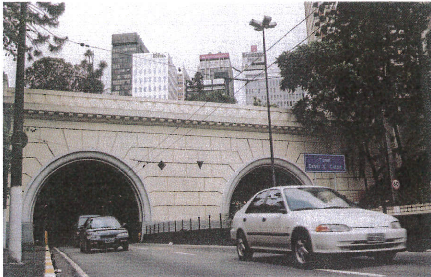
Túnel Daher E. Cutait, antes 9 de Julho, um dos mais antigos da cidade
