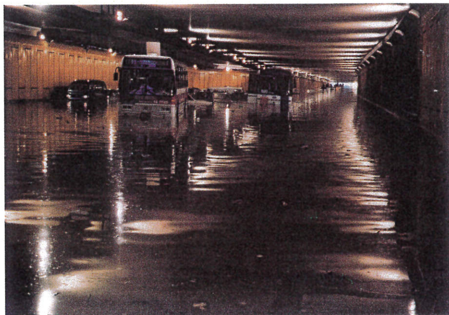
Túnel do Anhangabaú alagado, durante verão de 2000
