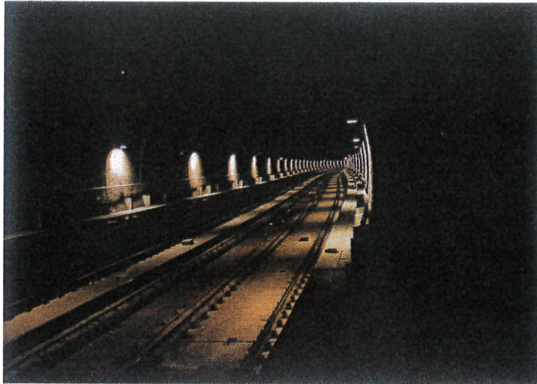
Visão interna do túnel ferroviário de 1.308 m, que possui uma saída de emergência com abertura para a rua
